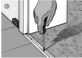
13 In der Schiene ist ein Dehnungsabstand von ca. 5 mm einzuhalten. Grundsätzlich müssen Holz Türstöcke in Bodenelementdicke mit einer Feinsäge abgeschnitten werden, damit der Boden eine Dehnungsmöglichkeit hat. Nach der Verlegung unbedingt die Abstandskeile entfernen. Sockelleisten (mit und ohne Clip-System montierbar) werden an der Wand befestigt – fertig.
