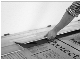
Die nächste Reihe wieder von links beginnen. Klicken Sie die Dielen einfach längsseitig zusammen. Eine Verleimung der Dielen ist nicht erforderlich.
