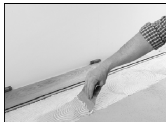
Alternativ ist bei der Verlegung von Parador Parkett eine vollflächige Verklebung möglich.
