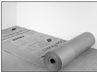
Unterboden auf vorbereitetem Untergrund auslegen.
